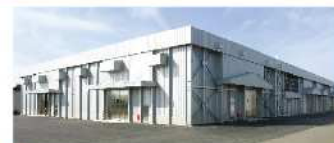
●玉葱・長芋貯蔵施設(平成18年建設)
