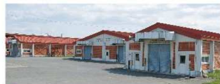
⑪ 種子馬鈴しょ貯蔵庫 5棟 (昭和54年建設)
