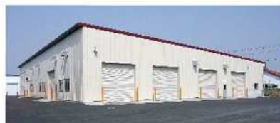
⑨ 種子馬鈴しょ共同選別施設 (平成21年建設)
