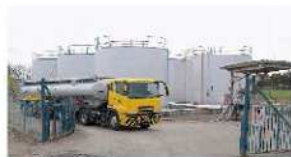
⑥ 燃料備蓄所収容力 1,200kℓ (昭和55年建設)
