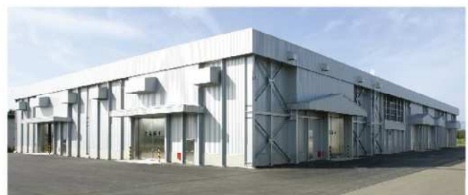
● 玉葱・長芋貯蔵施設（平成16年建設）
