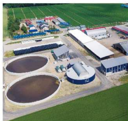
⑩ バイオガスプラント 能力42t/日発電能力最大150kwh(平成27年建設)
