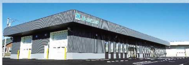
① 資材センター 981㎡ (令和4年建設)
