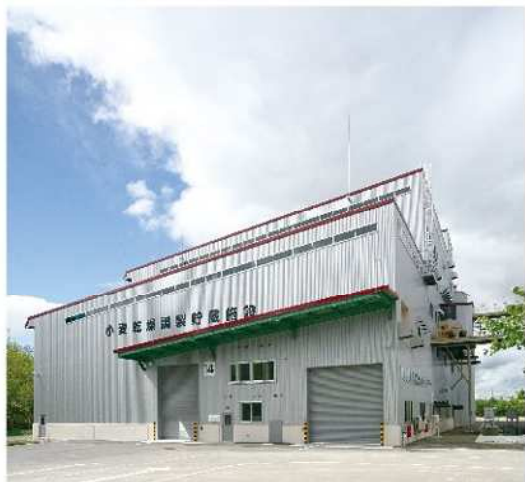
● 小麦乾燥調製貯蔵施設（平成20年建設）
